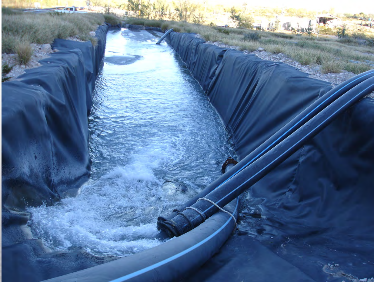
DESCARGAS DE LOS POZOS DE ACHIQUE DE LA MINA LA PLATOSA: GEMELO V3, GEMELO V4 Y VERTICAL V2
