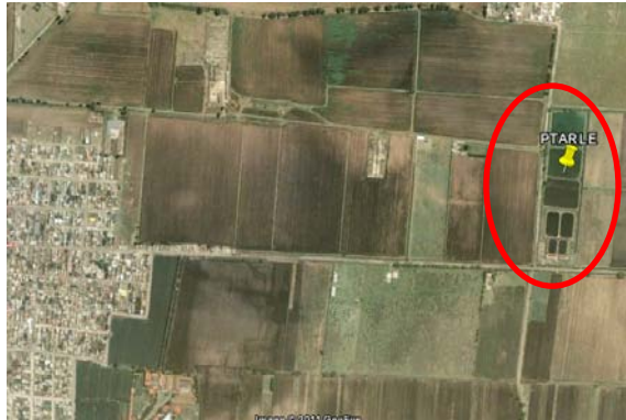
LAGUNAS DE ESTABILIZACIÓN
