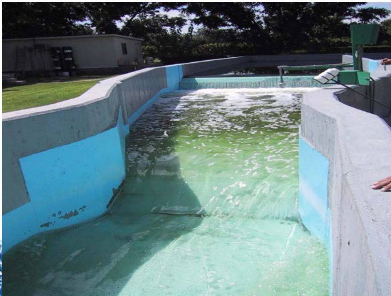
AFORADOR PARSHALL Y CANAL DE DESCARGA
