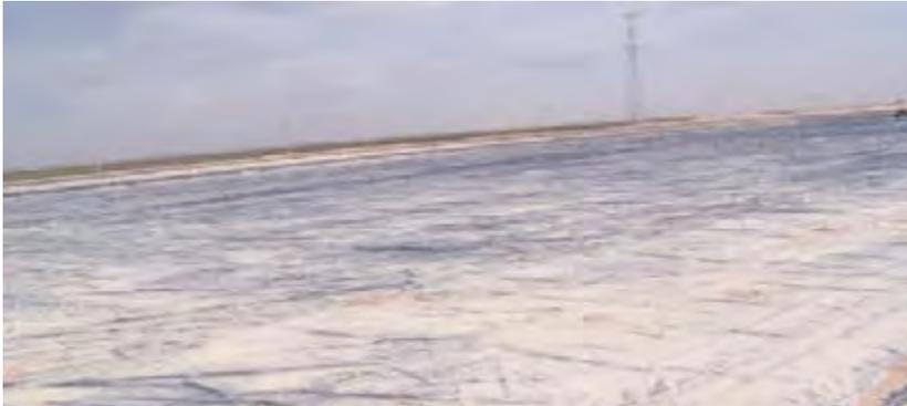
Las lagunas anaeróbicas y facultativas, están impermeabilizadas en el fondo y los taludes con telas de polipropileno, además los taludes tienen enrocamiento para evitar erosión y pérdidas por infiltración.
