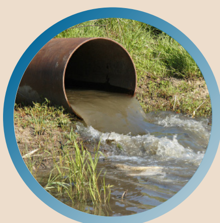
Descarga de aguas negras domésticas
