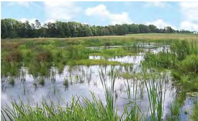
Al fluir el agua residual a través del humedal esta se va tratando con procesos como sedimentación, filtración, oxidación, reducción, absorción y precipitación. Este tipo de humedal se utiliza para el tratamiento de aguas urbanas y agrícolas debido a su capacidad para soportar aumentos en el flujo y niveles de agua cambiantes.
