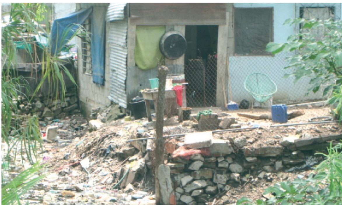
Figura 31. Construcción de viviendas en los márgenes del río que sirve como drenaje.
