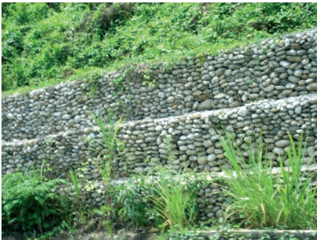
Figura 18. Establecimiento de gaviones en el municipio de Tacotalpa, Tabasco.
