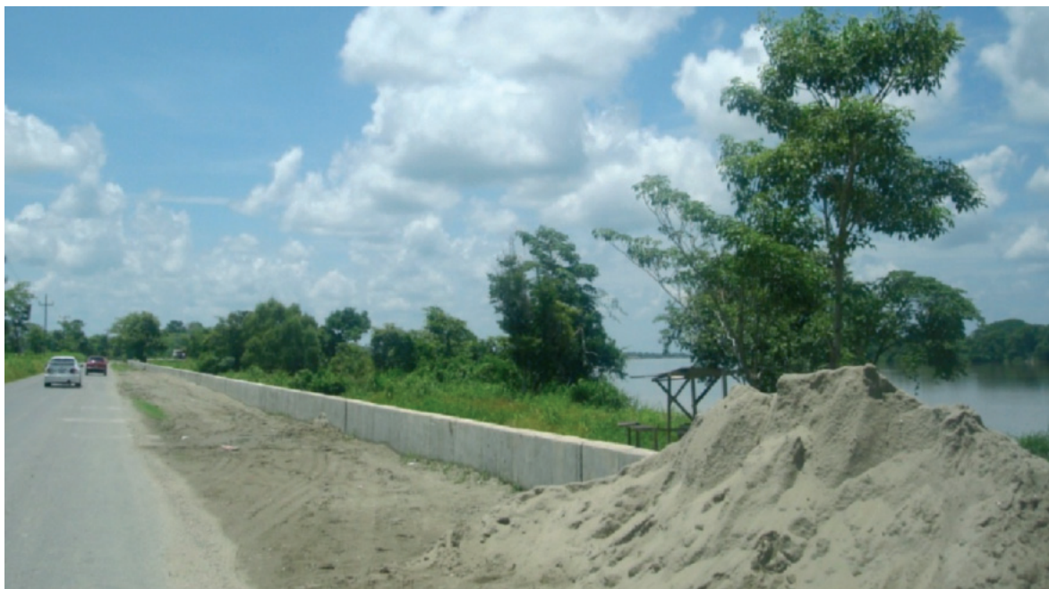
Figura 23. Construcción de la barda a las orillas del río Usumacinta en Jonuta.
