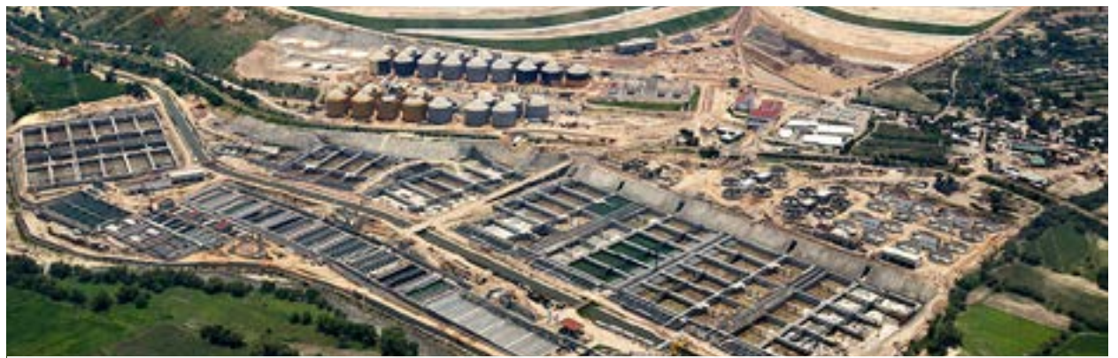
Planta de Aguas Residuales de Atotonilco Atotonilco WWTP
