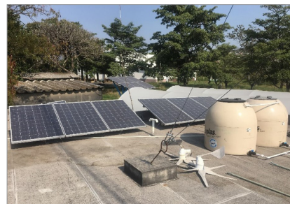
Figura 2. Sistema de Bombeo solar.
