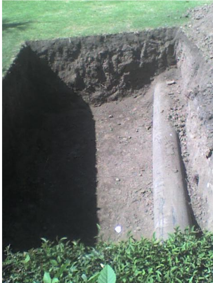
Excavaciones para la instalación del medidor electromagnético.
