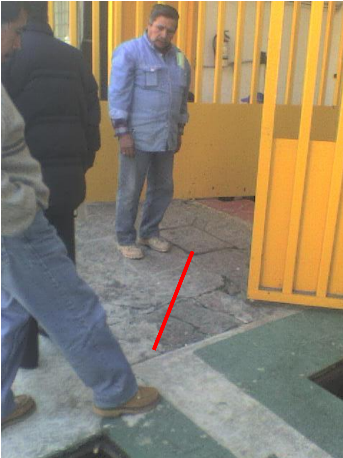
Trayectoria propuesta para la canalización del cable de transmisión del medidor.
