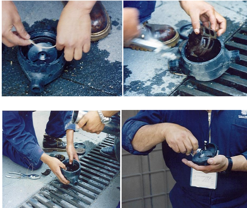
Figura 30. Desarmado de la cámara de un medidor.
