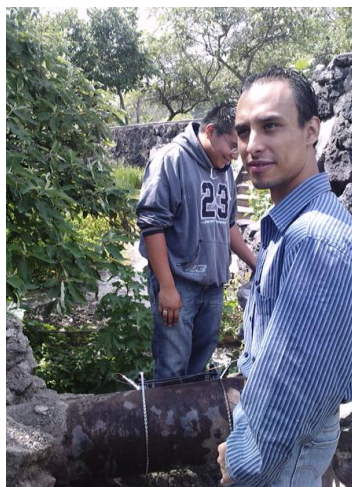
Figura 22. Medición de pérdidas en el Sector 4.
