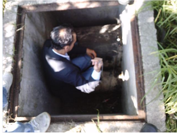
Figura 24. Medición de pérdidas en el Sector 5.
