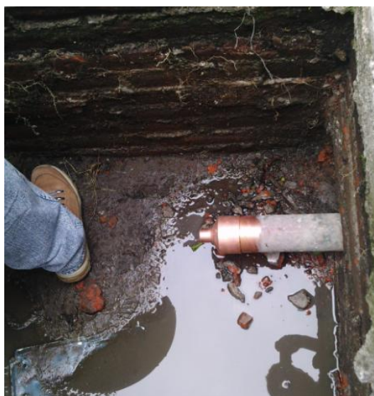
Figura 22. Reducción tipo Bushing para tuberías de cobre.
