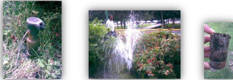
Figura 18. Reparación de fugas del tipo mayormente presentado en la conducción
