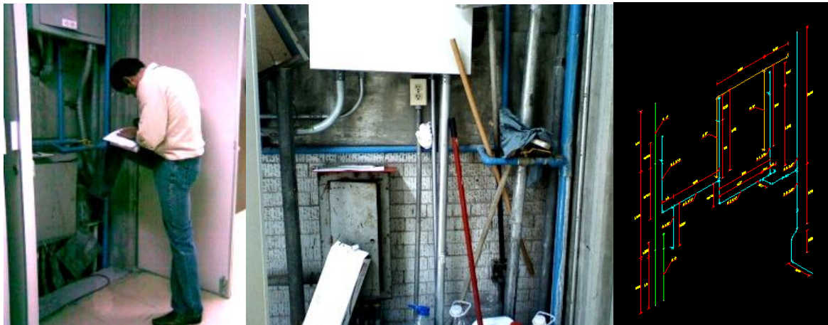
Figura 69. Levantamiento de las instalaciones del Edificio 5 del Instituto de Ingeniería
