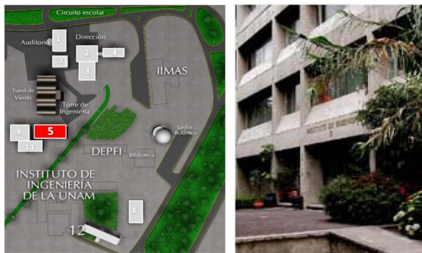
Figura 72. Ubicación del Edificio 5 dentro del Instituto (en rojo) y entrada al mismo (Derecha)
