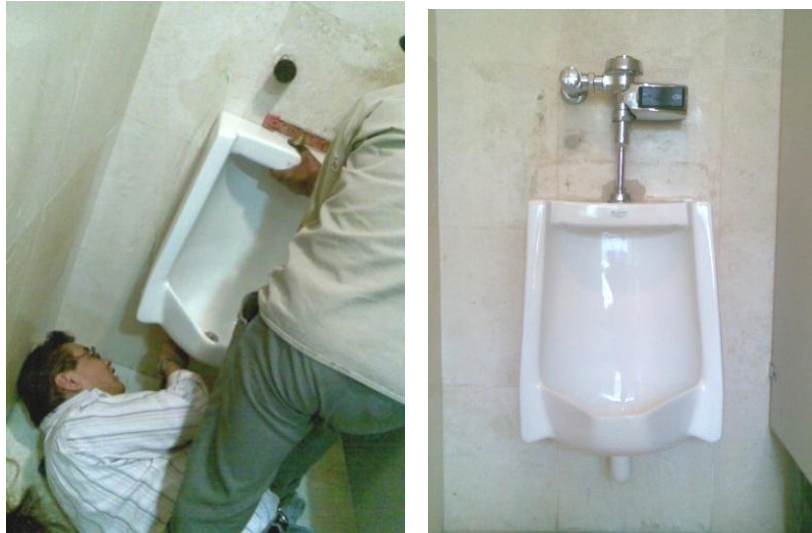
Figura 97. Instalación (izquierda). Mueble instalado (derecha).
