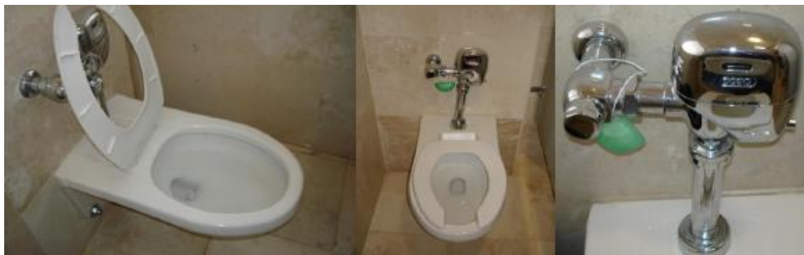
Figura 88. Fotografías de los modelos de las tazas sustituidas. Se determinó su consumo promedio en 9.7 lpf con un máximo de 15.25 lpf
