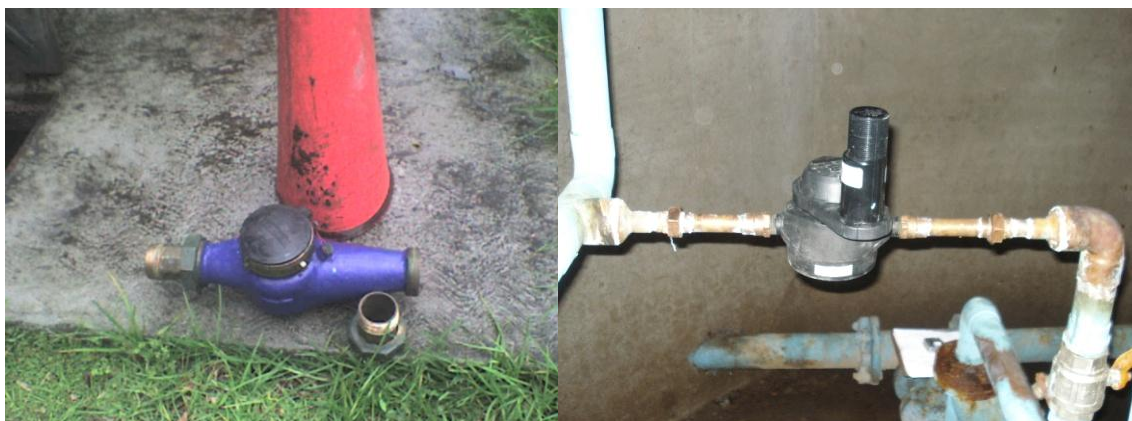
Figura 75. Sustitución del medidor del edificio 5. Medidor de 2" (Izquierda) y medidor de \frac{3}{4} " (Derecha).
