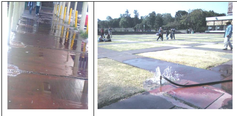
Figura 54. Deficiencias en el sistema de riego actual
