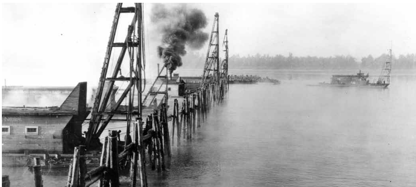
Maquinaria para el control de las aguas del Río Fuerte, Los Mochis, Sinaloa, 1934
