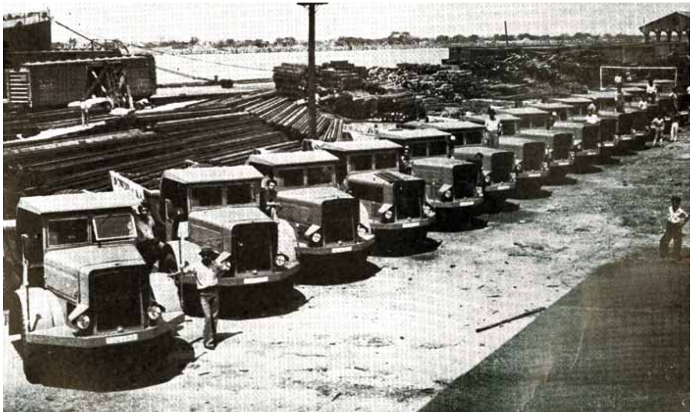
Camión "Huge" descargando arena para la cortina de la presa El Palmito, Durango, 1940 / Flotilla de camiones para trabajos de irrigación, 1940
