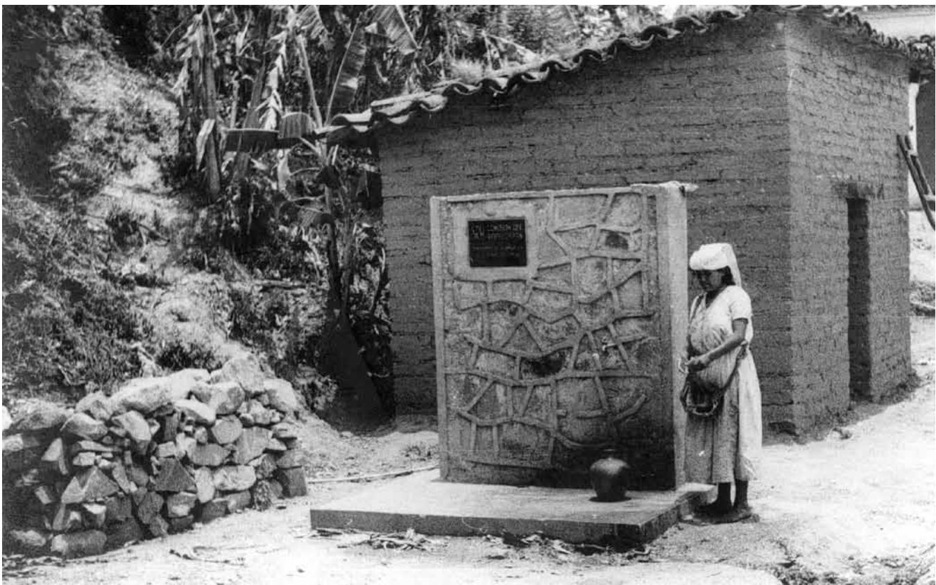
Tanque elevado, González, Tamaulipas, 1970 / Hidrante para servicio público, Yojovi, Oaxaca, 1970
