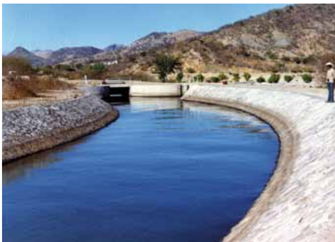
Canal principal de la presa La Calera, Zirándaro, Guerrero, 1970
