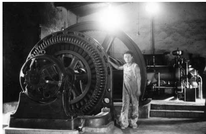
Interior de hidroeléctrica, Pedricena, Durango, 1917
