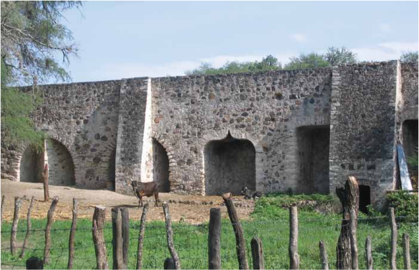
Presa de la Hacienda de Santa Catarina, San Luis Potosí, 2005
