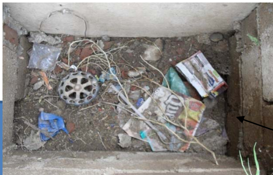
Cajas parcialmente azolvada y totalmente azolvada
