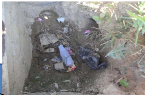
Cajas parcialmente azolvada y totalmente azolvada
