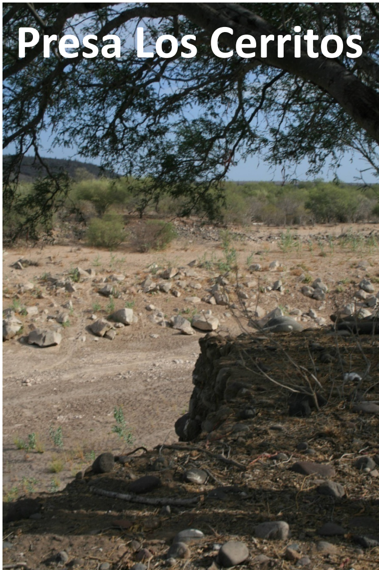
Escarpe formado por la ruptura del represo
