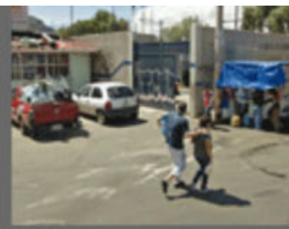
Planta de Bombeo "La Qu"
