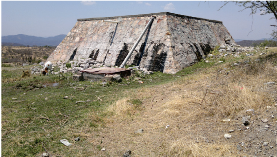
Ilustración H - 4. Tanque de regulación en Tehuitzingo, Puebla
