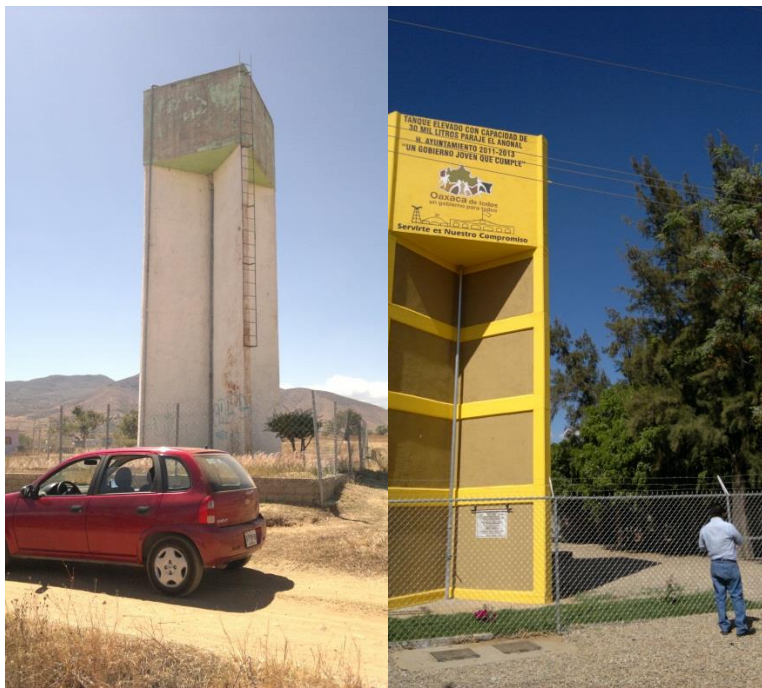
Ilustración B - 5. Tanques elevados (Tanque 1 izquierda y tanque 2 derecha)
