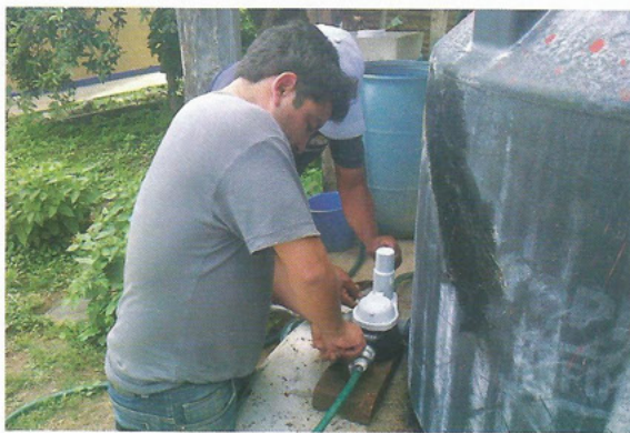
Instalación de micromedidores para conocer el volumen de agua que llega a los hogares.
