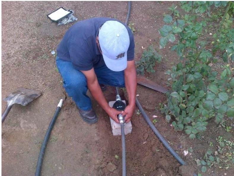
**Figura 43. Instalación de equipos de medición para la estimación de la dotación de agua por parte de los habitantes de San Francisco Telixtlahuaca**
