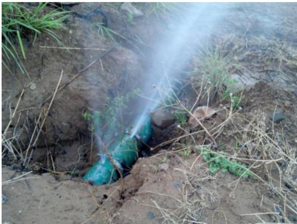
**Figura 14. Fuga en línea de conducción**
