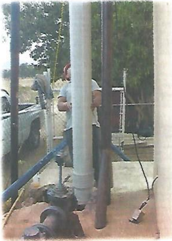
Colocación de Ademe Nuevo de PVC - 8" de Ø en el Pozo 3, especial para pozo.
