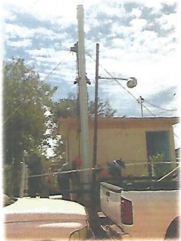
Colocación de Ademe Nuevo de PVC - 8" de Ø en el Pozo 3, especial para pozo.
