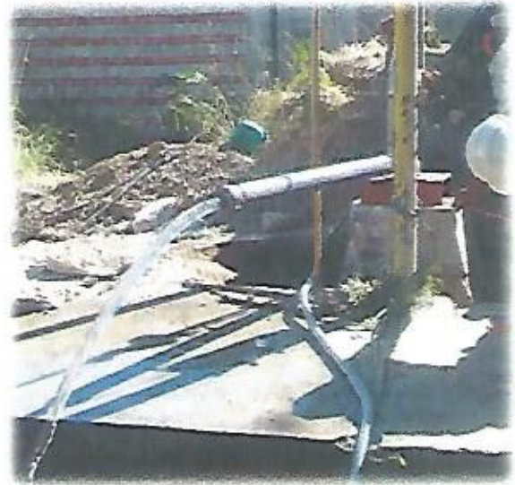
Desarrollo de Limpieza con hidropresión en y AFORO en Pozo 1
