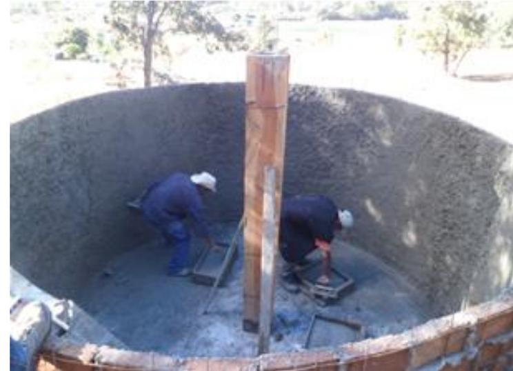
En cisternas de 20 a 50 m<sup>3</sup> se introduce una columna central, Malla electro-soldada # 6 con varilla en losa y ci
