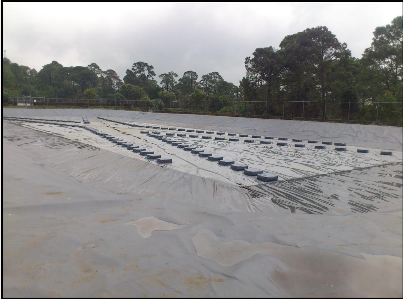
Hoya de captación pluvial con cubierta flotante rehabilitada en Coajumulco, Huitzilac, Morelos. (2012)
