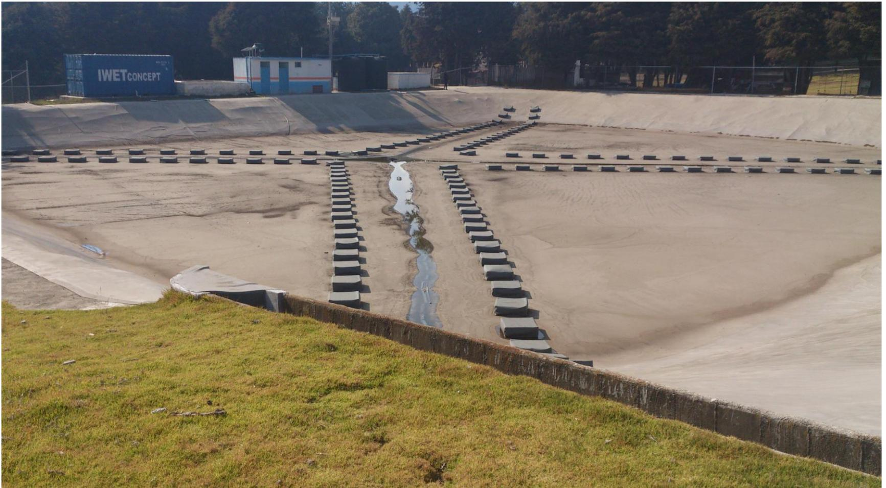
Hoya rehabilitada de captación pluvial con tapa flotante en Fierro del Toro, Huitzilac, Morelos. (2012)
