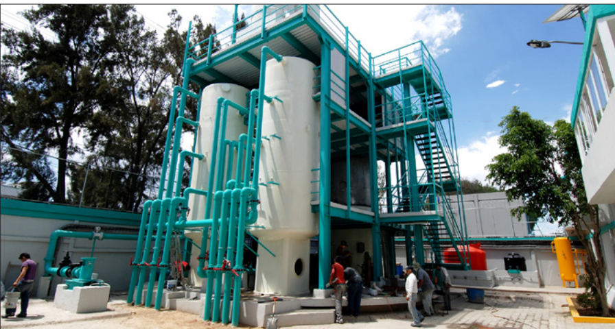
Infraestructura en construcción.
