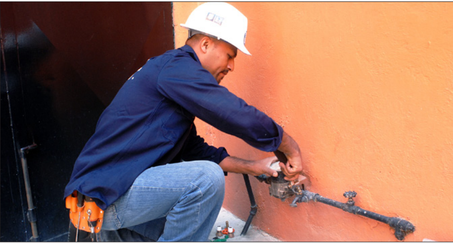
Trabajos para la reducción de fugas.
