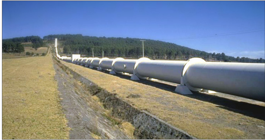
Tramo del Sistema Cutzamala.
