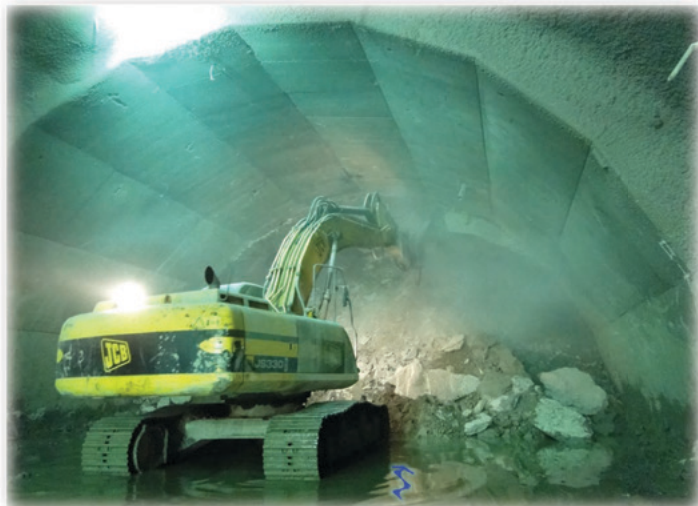
Sección de casquillos en las zonas de falla
