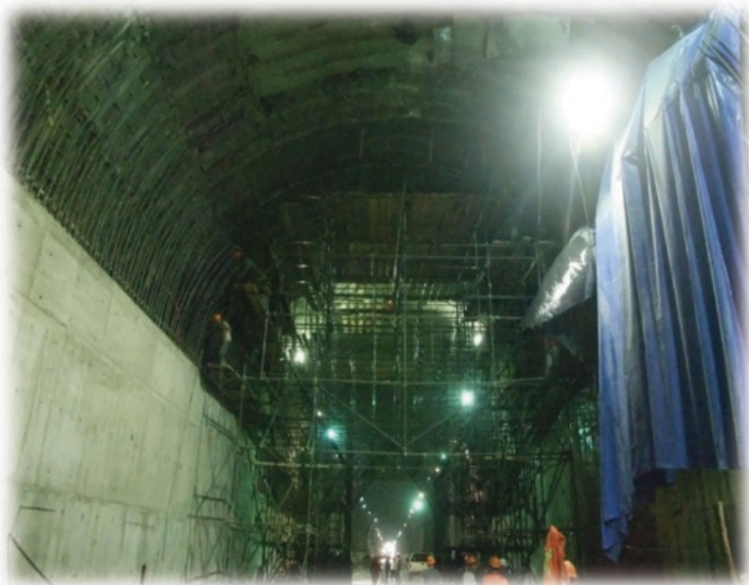
Sección de casquillos en las zonas de falla
