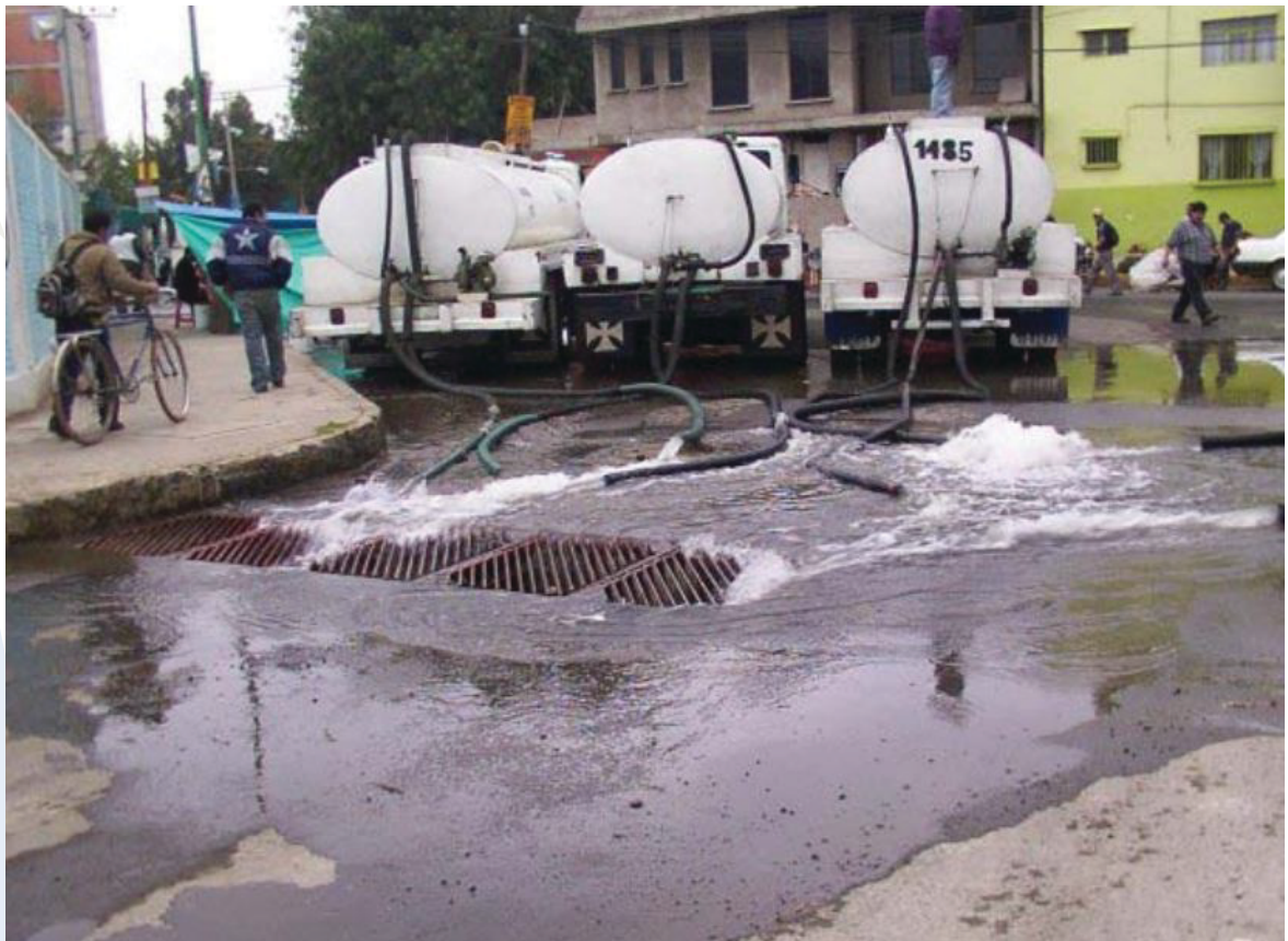
Prueba de pozo de absorción en Iztapalapa
