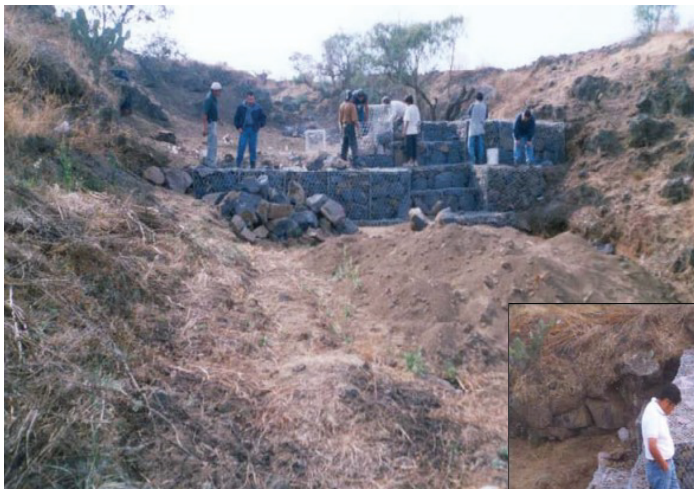
Presas de gaviones en zonas altas de Tlalpan, Alvaro Obregon, Cuajimalpa y Ajusco.
