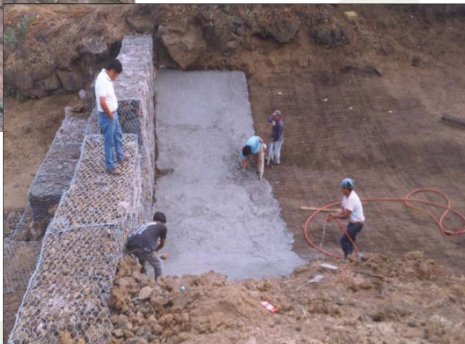
Presas de gaviones en zonas altas de Tlalpan, Alvaro Obregon, Cuajimalpa y Ajusco.
