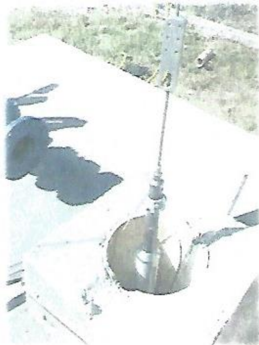
Desmontaje de equipo de Bombeo y Videgrabación de Pozo 7
