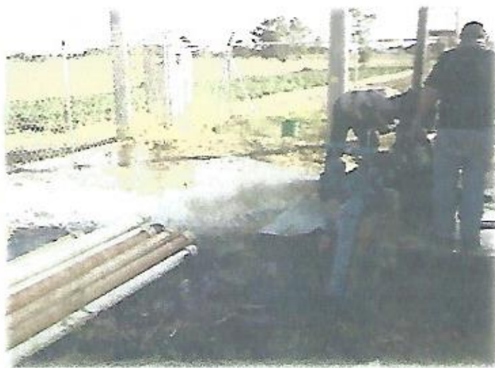
Proceso de Lavado de Pozo con Dispersor de Arcillas e Hidropresión y Pruebas a Bomba en Pozo 5
