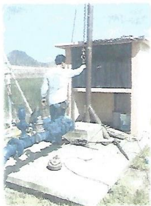
Desmontaje de equipo de Bombeo y Videgrabación de Pozo 7
