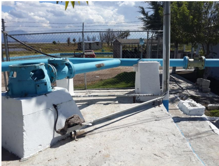
Ilustración 2 Obra de captación y bombeo.
