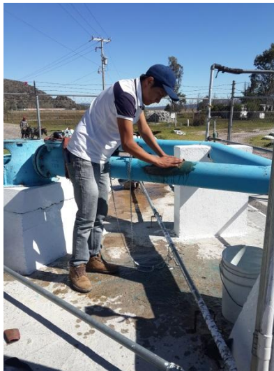
Ilustración 5 Elección de tramo de tubería.
