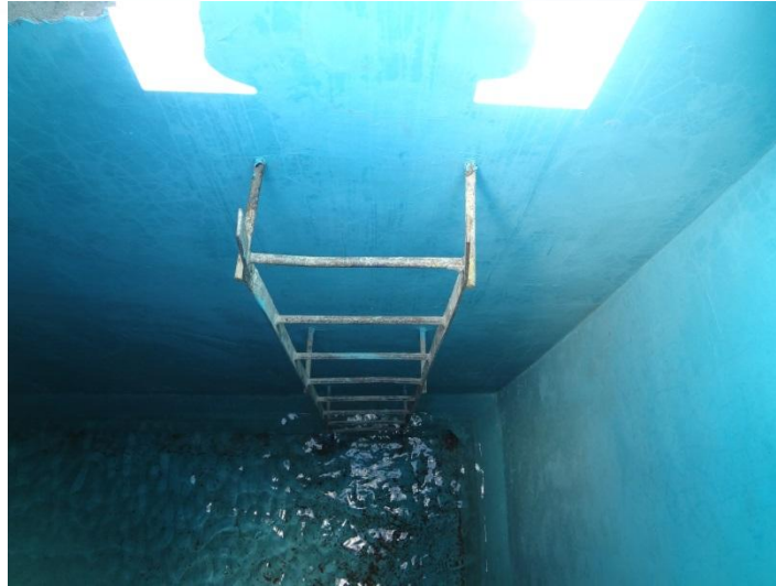
Ilustración 6 Escalera para ingreso al tanque.
