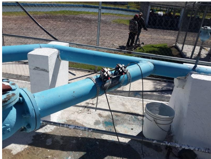
Ilustración 7 Ultrasónico colocado.
