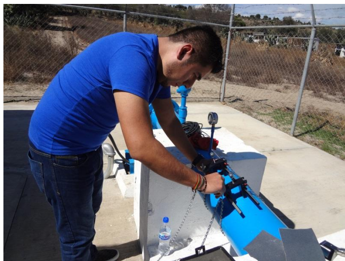
Ilustración 6 Ultrasónico colocado.
