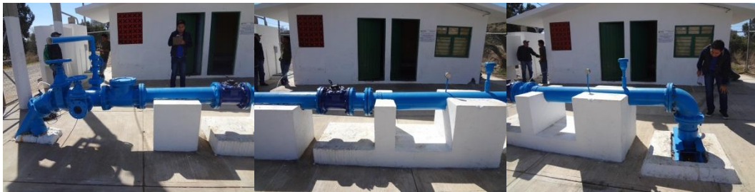
Ilustración 2 Línea de conducción y accesorios para el control del flujo.
