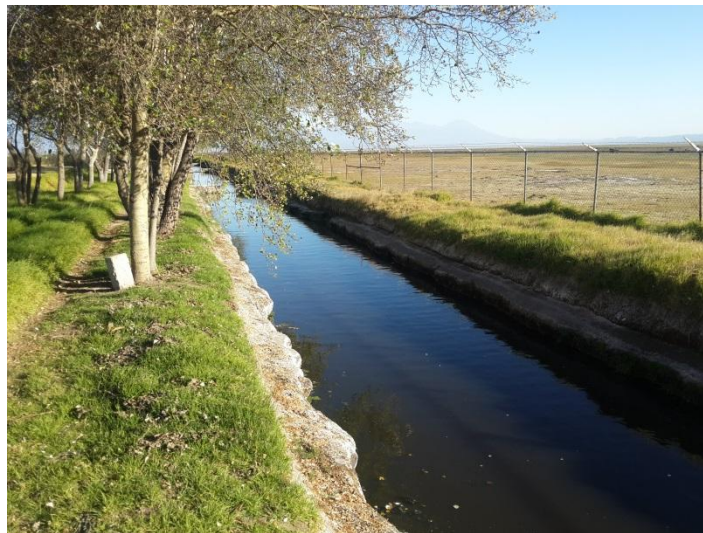
Figura 12 Canal de descarga.
