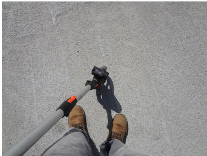
Ilustración 3 Medición con odómetro.
