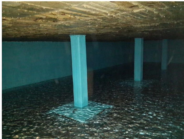
Ilustración 9 Columnas para soporte de losa.
