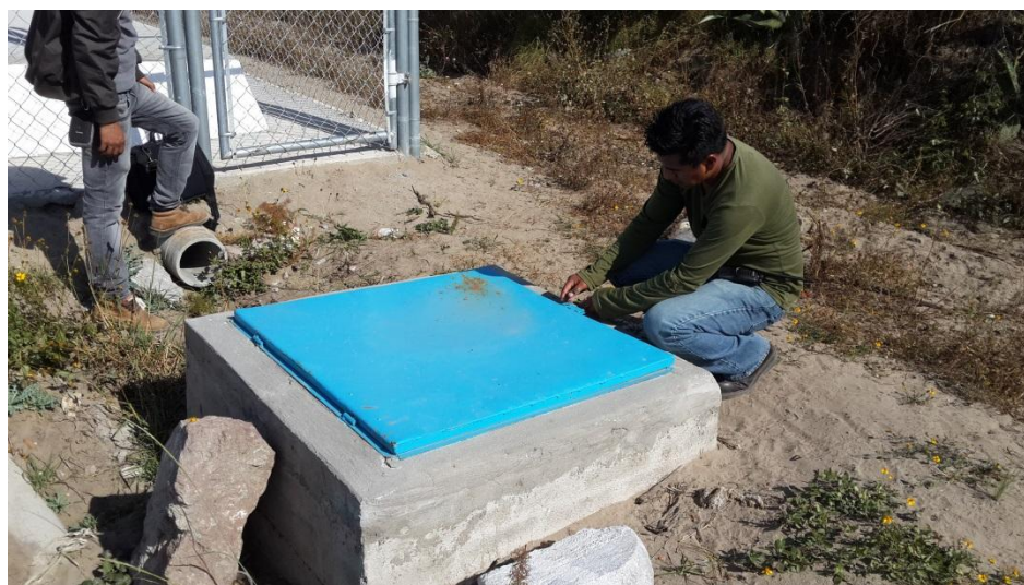
Ilustración 3 Tubería de salida del tanque.
