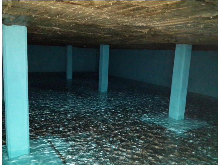
Ilustración 8 Vista al interior del tanque.
