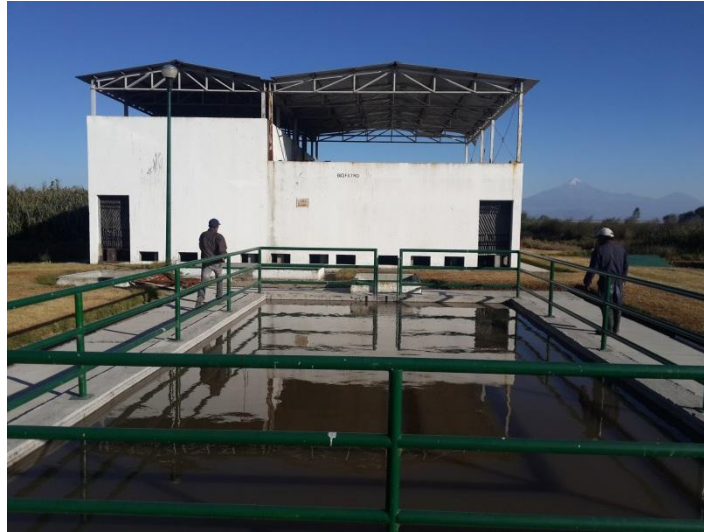
Figura 8 Tanque de almacenamiento y biofiltro al fondo.
