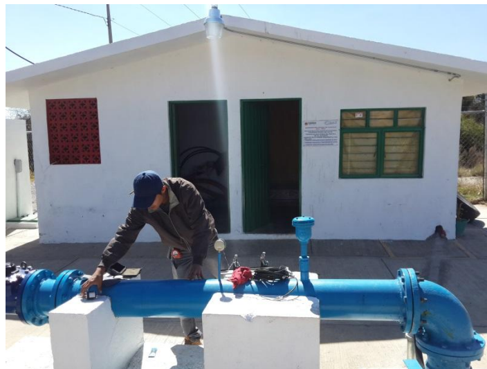
Ilustración 4 Elección de tramo de tubería.
