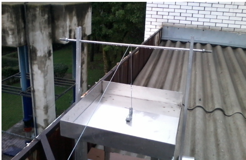
INSTALACIÓN DE CONTENEDOR
