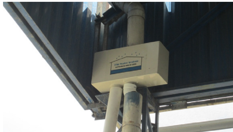
INSTALACIÓN DE VÁLVULA
